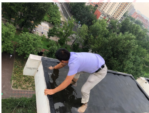
▲ 疏通屋顶雨漏管
