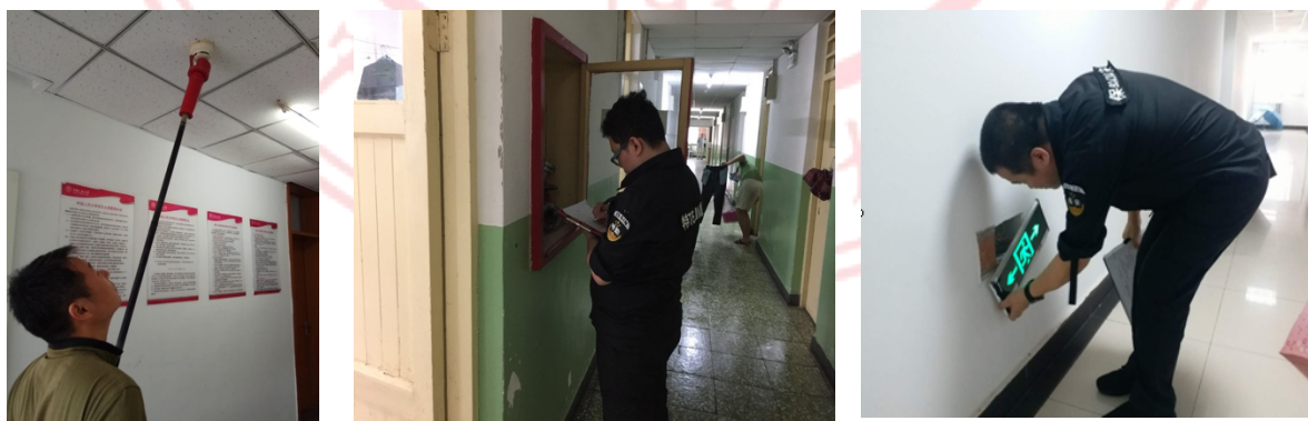
▲查验烟感探测器（左）、消防栓（中）、安全出口指示灯（右）
