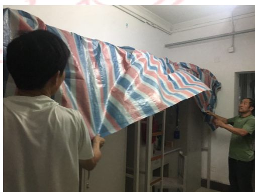
▲ 为顶层宿舍铺设苫布
